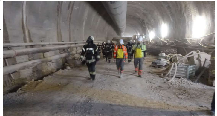
Die Rettungseinheit mit Tunnelbauarbeitern auf dem Weg ins Freie
